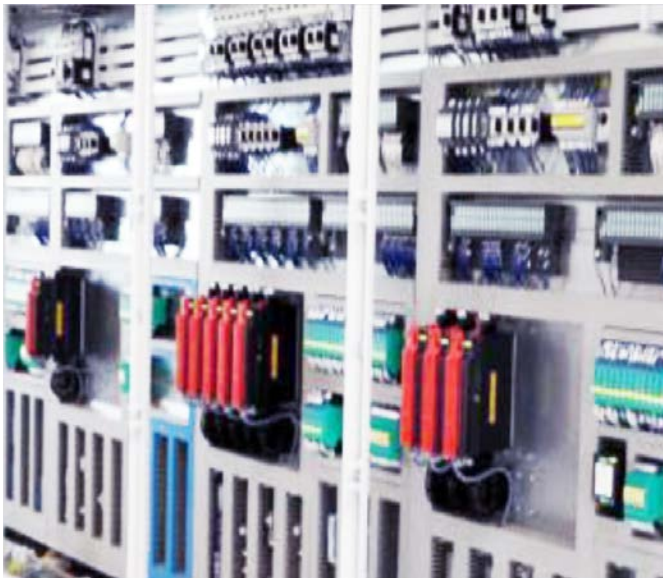
Refrigeración de equipos
