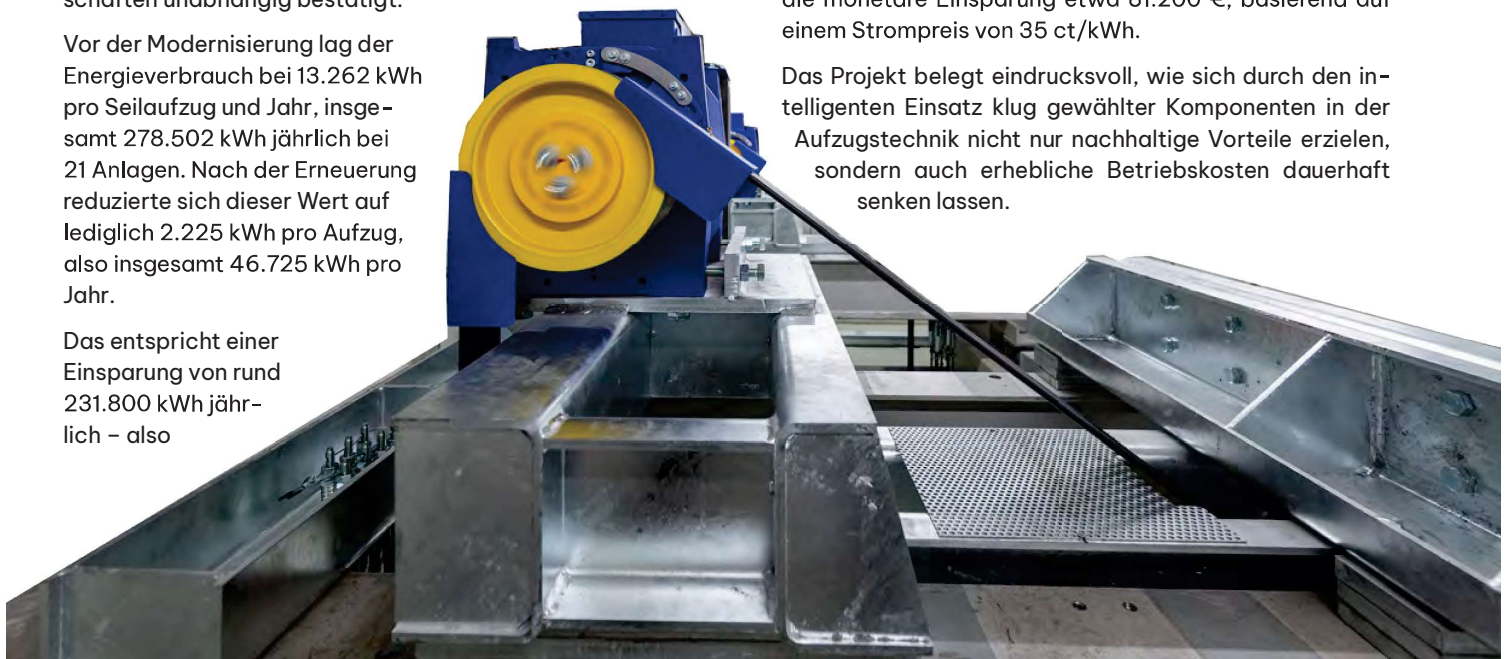
Neu: Getriebeloser ZAtop-Antrieb mit kunststoffummantelten Seilen
