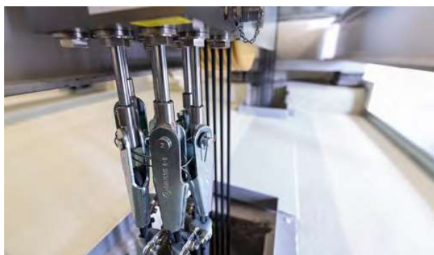
New - Balance system for compensating rope tension Photo: BUTZ AUFZÜGE GmbH
